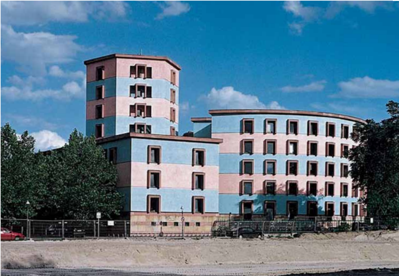
Wissenschaftszentrum Berlin Blick von Süden (Reichpietschufer) Abb.: Senatsverwaltung für Stadtentwicklung und Umwelt
